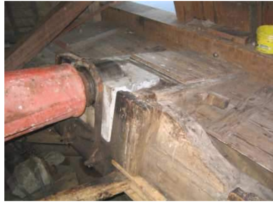
Lagering van pen gietijzeren bovenas: hardsteen.
