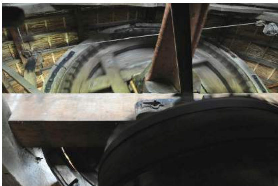
Het grote asrad met daaromheen de vangstukken. Het asrad drijft de bovenbonkelaar ("tandwiel") van de (konings)spil aan.
